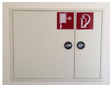
**Abb. 4.4.1: Wandhydrantenkasten (hier mit Feuerlöscher kombiniert)**
