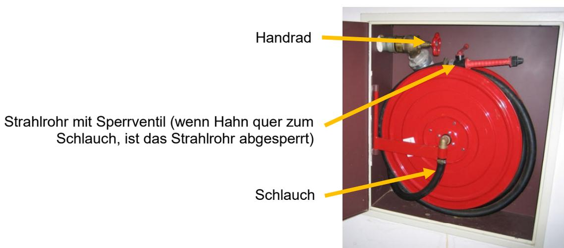
**Abb.4.4.2: geöffneter Wandhydrantenkasten**
