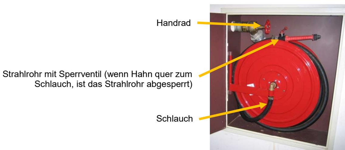
**Abb.4.4.2: geöffneter Wandhydrantenkasten**
