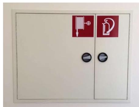
**Abb. 4.4.1: Wandhydrantenkasten (hier mit Feuerlöscher kombiniert)**
