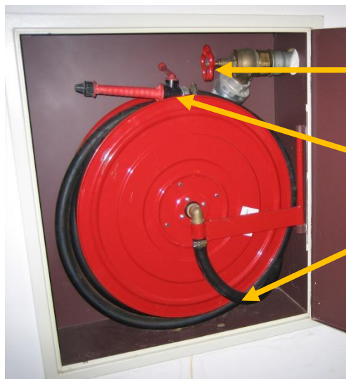
Abb.4.4.2: geöffneter Wandhydrantenkasten
