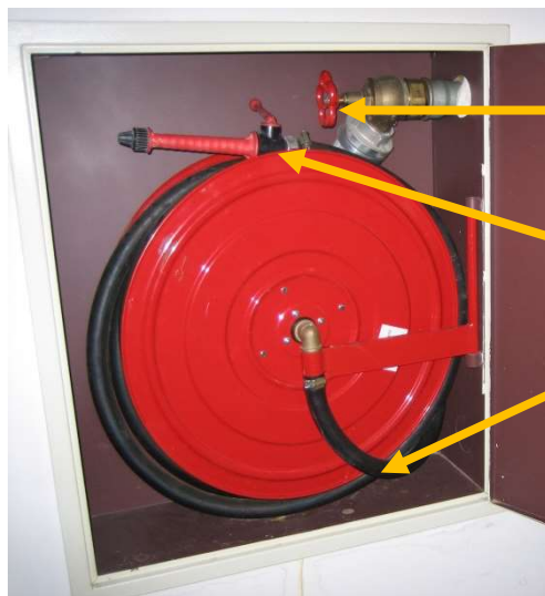
Abb.4.4.2: geöffneter Wandhydrantenkasten
