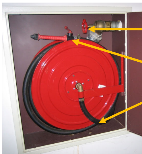
Abb.4.4.2: geöffneter Wandhydrantenkasten
