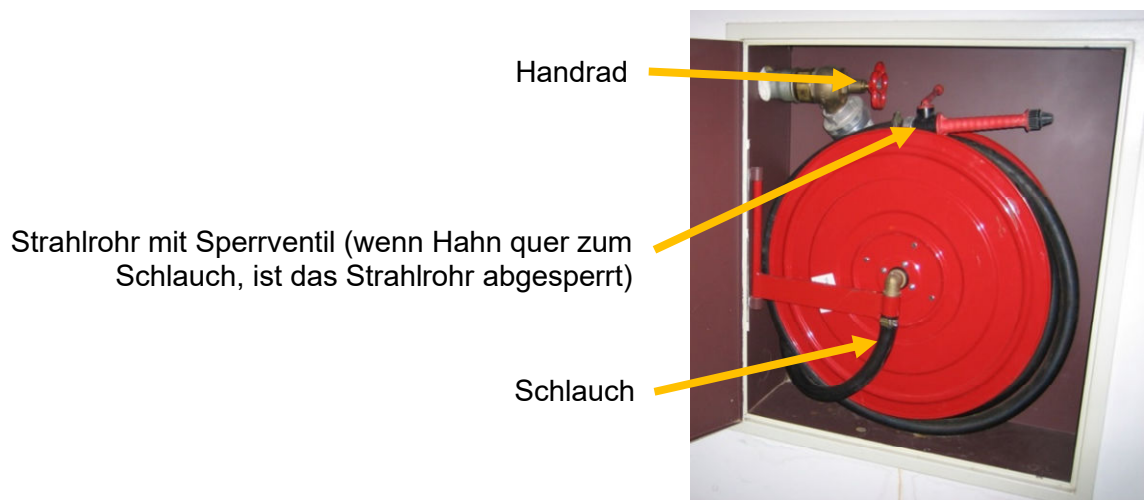
Abb.4.4.2: geöffneter Wandhydrantenkasten
