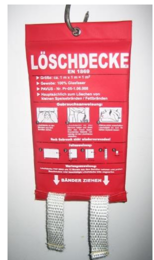
Abb. 4.3: Löschdecke
