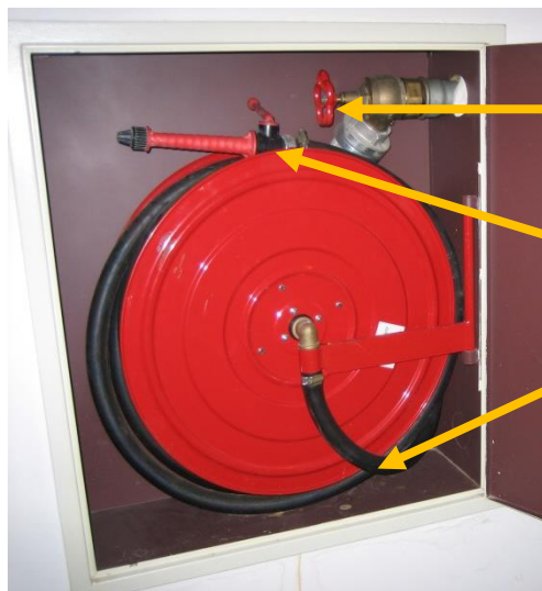
Abb.4.4.2: geöffneter Wandhydrantenkasten
