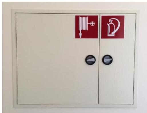
**Abb. 4.5.1: Wandhydrantenkasten (hier mit Feuerlöscher kombiniert)**
