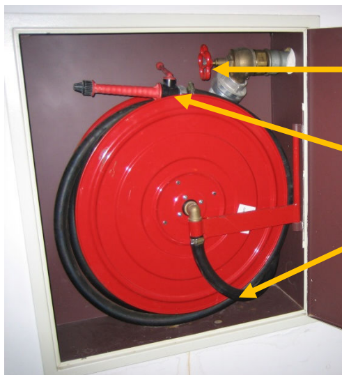
Abb.4.4.2: geöffneter Wandhydrantenkasten
