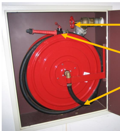
Abb.4.4.2: geöffneter Wandhydrantenkasten
