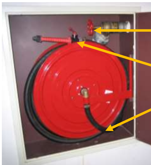
Abb.4.4.2: geöffneter Wandhydrantenkasten
