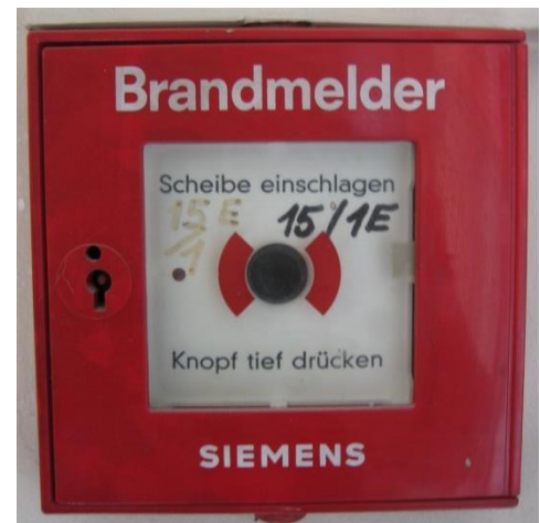
Abbildung 2: Hausalarm - Druckknopfmelder
